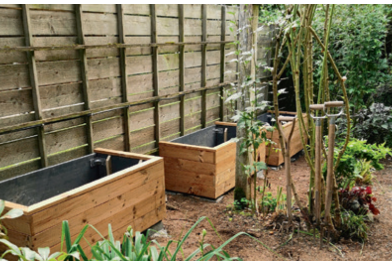
Die Hochbeete wurden platziert.
