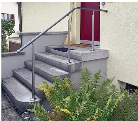
Handwarmer Handlauf bei einer Aussentreppe mit Podest in Antrazithgrau.
