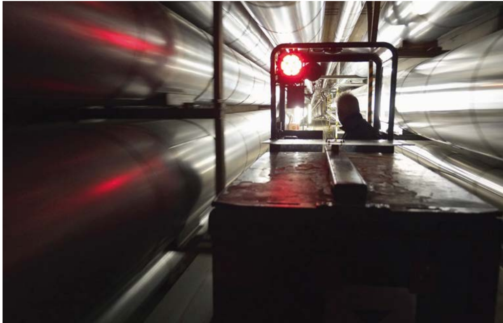
Unterwegs im Fernwärmestollen
