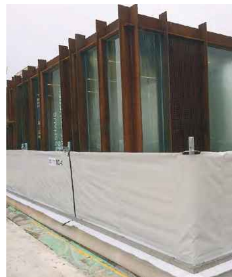
Öffentliches Bauvorhaben der Stadt Biel: Objektschutz kann vielfältig gewährleistet werden.
