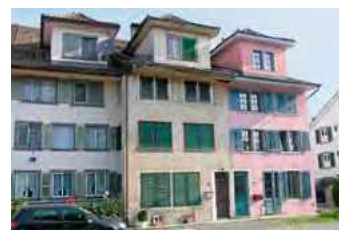
Stäfa Renovationsobjekt im schönen Stäfa
