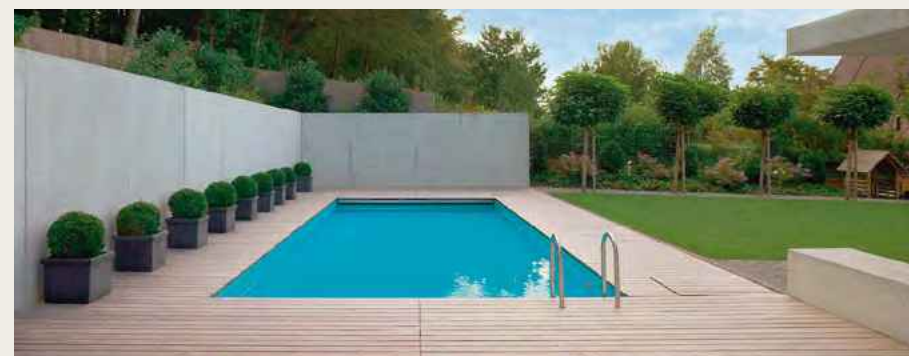
Gesamtansicht Gartenschwimmbad in Seuzach (Architekten Kollektiv AG, Winterthur). Bild Thomas aus der Au, Winterthur
