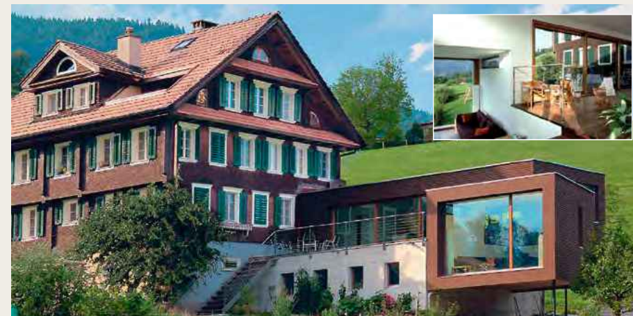
Holzbau-Erweiterung eines Bauernhauses in Stalden OW. Architekt: Roger Duvoisin, Luzern. Bilder: Franca Pedrazzetti, Luzern; Gerti Kaspar, Udligenswil/Lignum
