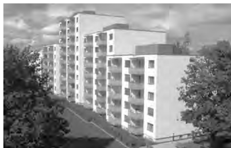
Erneuerung von 119 Wohnungen nach MINERGIE-Standard
