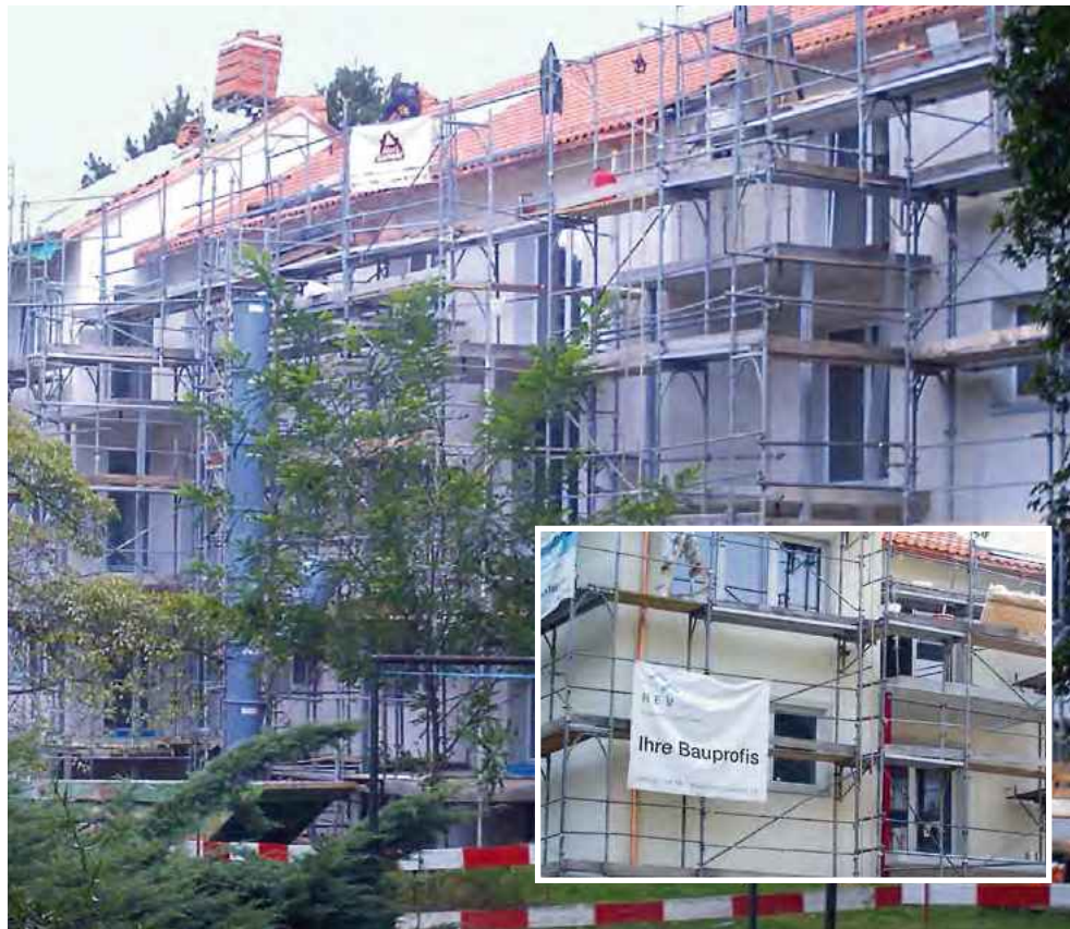
Ansicht der Fassade von Westen her.
