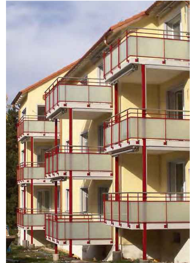
Ansicht von Süden: Hier fallen die deutlich grösseren Balkone auf.
