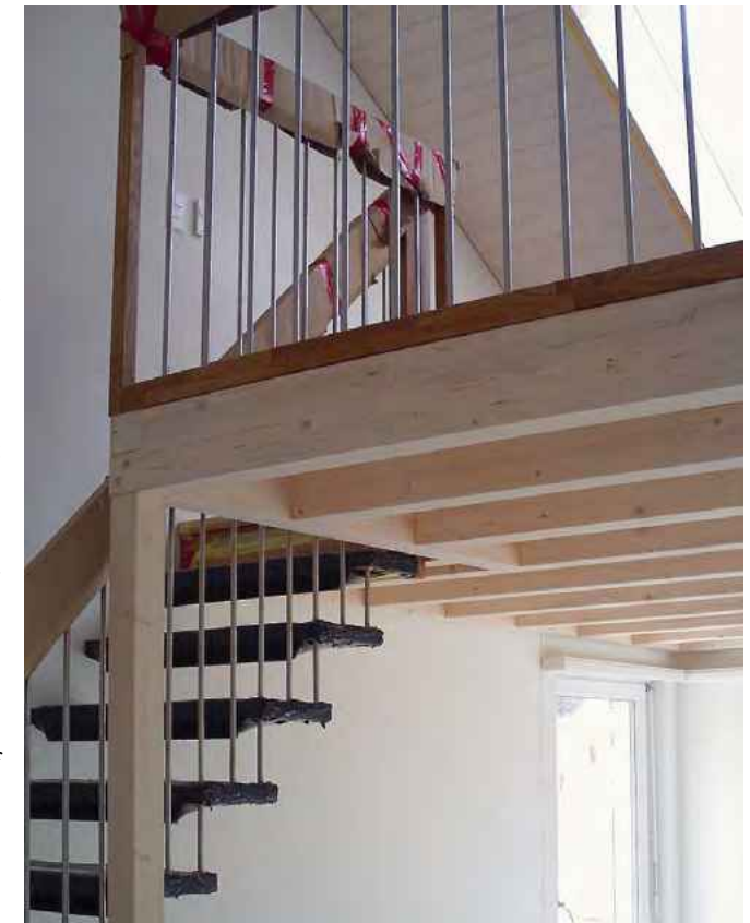
Die fertig montierte Treppe führt in die Galerie unter dem Dach.
