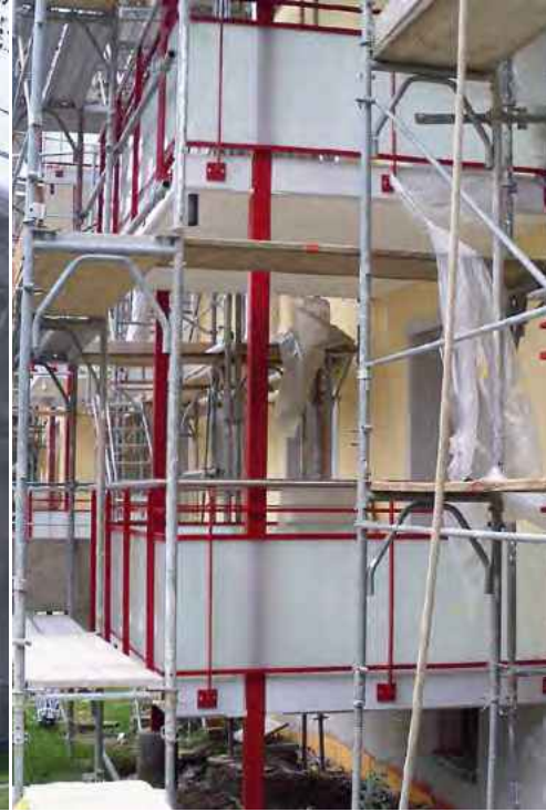
Alle Balkone werden vergrössert.
