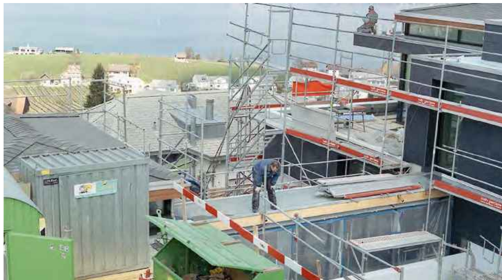
Bau eines Wohnhauses am Zürichsee: Ist der Bauherr eine Privatperson oder ein gewerbmässiger Liegenschaftshändler?
