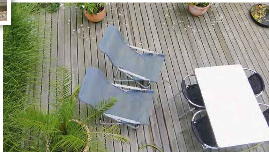
Terrassenrost für ein Einfamilienhaus in Oberkirch. Weisstanne druckimprägniert KDS Braun, Aufnahme nach fünf Jahren ohne Nachbehandlung.
