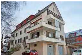
Zürich-Seebach 817 m² Bauland mit bestehendem Mehrfamilienhaus
